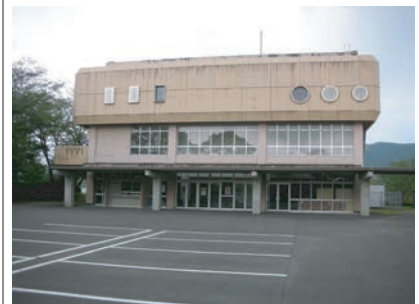
地質調査を行う宮之城文化センター
