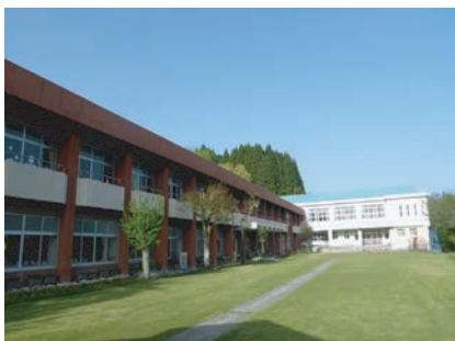
測量を行う旧永野小学校
