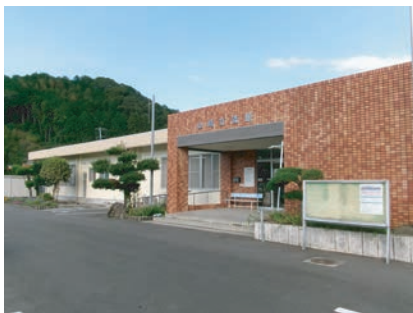
フェンス修繕を行う山崎交流館
