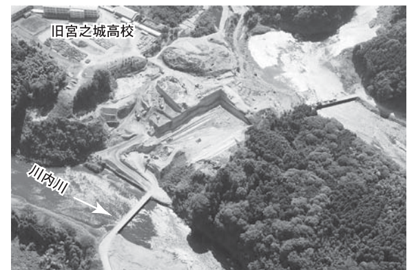
推込分水路 掘削状況(平成21年11月末現在)
