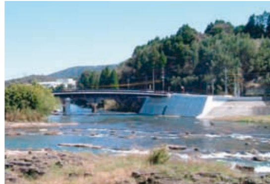
完成した川原橋全景
