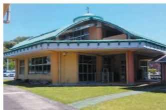
学びの多様化学校宮之城中学校分教室外観
