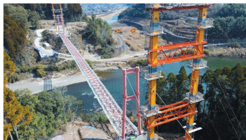
工事施工現場の様子
