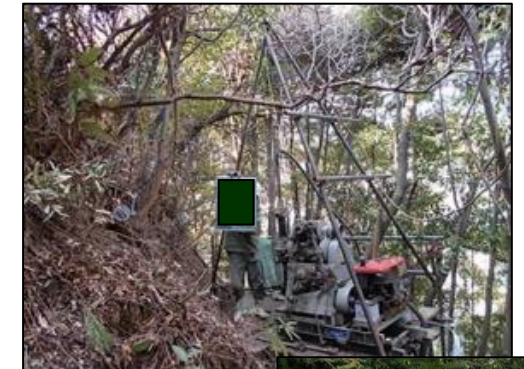
ボーリング調査
