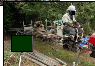
モノレール仮設
