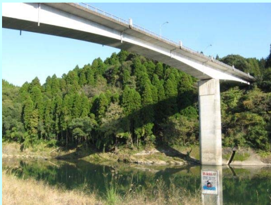
橋梁名:鴛鴦橋 橋種:コンクリート橋(PC ポス텐箱桁橋) 架設年:1986(S61)
