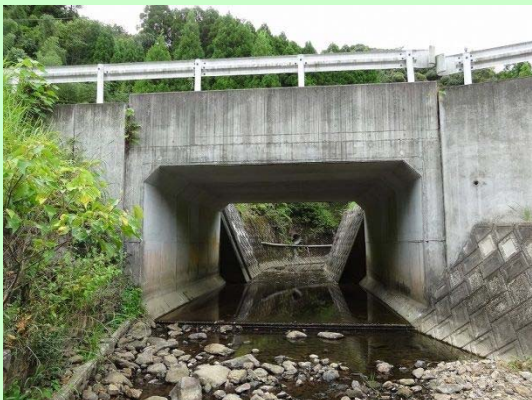
橋梁名: 大山口 2 号橋 橋種: コンクリート橋(RC BOX) 架設年: 2004(H16)
