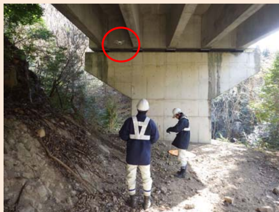
・UAV を用いた近接目視点検
