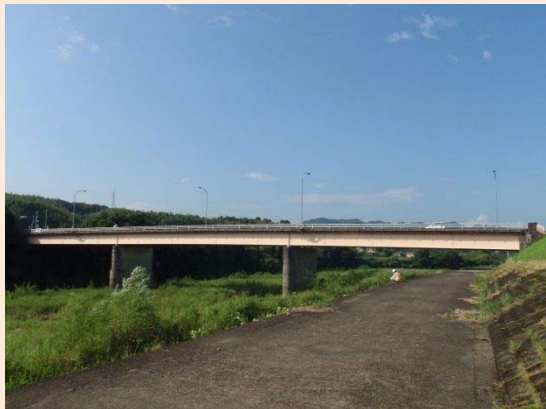
橋梁名:新湯田橋 橋種:鋼橋(鈑桁橋) 架設年:1975(S50)
