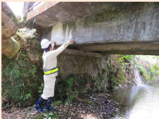
・地上からの近接目視点検状況
