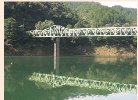
橋梁名:平江橋 橋種:鋼橋(ゲルバートラス橋) 架設年:1962(S37)
