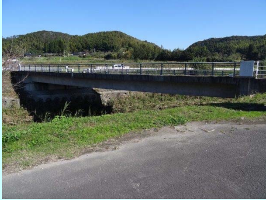
橋梁名:新中間橋 橋種:コンクリート橋(PC ポス텐床版橋) 架設年:2002(H14)
