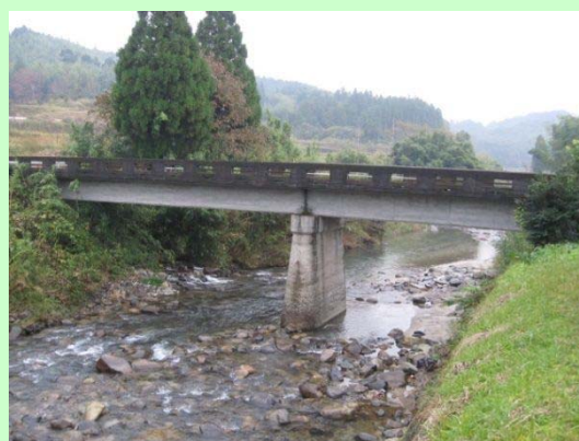
橋梁名: 中間橋 橋種: コンクリート橋(RC T 桁橋) 架設年: 1957(S32)
