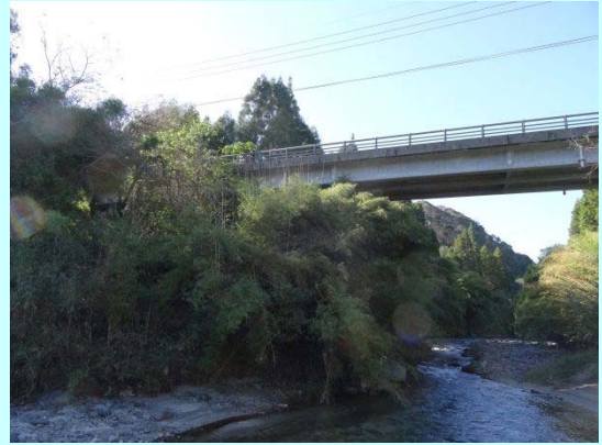
橋梁名:ちくりん橋 橋種:コンクリート橋(PC ポス텐T桁橋) 架設年:1990(H2)
