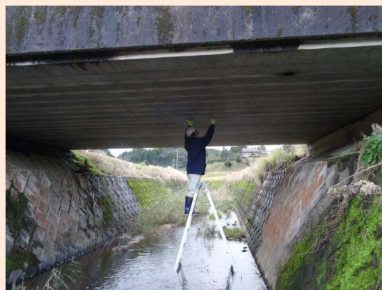
・梯子・脚立を用いた近接目視点検
