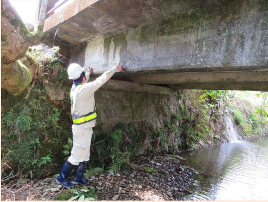
・地上からの近接目視点検状況
