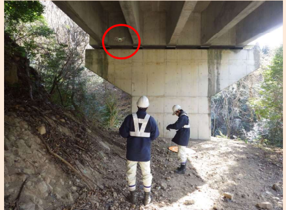
・UAV を用いた近接目視点検
