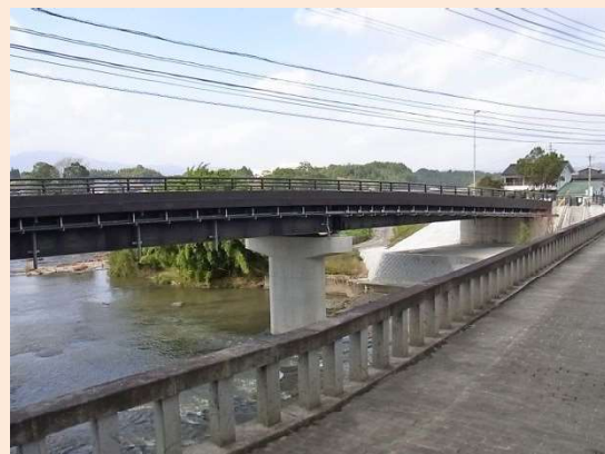
橋梁名: 川原橋 橋種: 鋼橋(鋼床版鈑桁橋) 架設年: 2010(H22)
