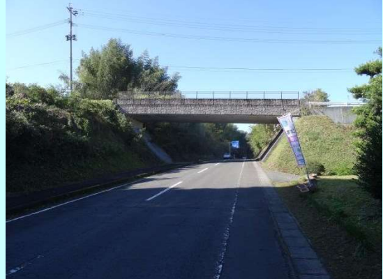
橋梁名: 松尾橋 橋種: コンクリート橋(PC プレテン床版橋) 架設年: 1996(H8)
