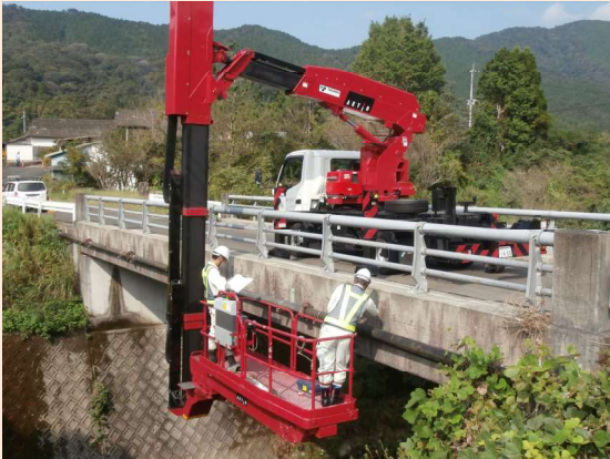
・橋梁点検車を用いた近接目視点検状況
