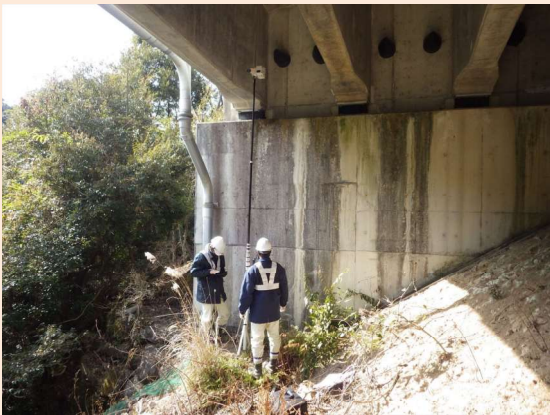
・ポールカメラを用いた近接目視点検状況
