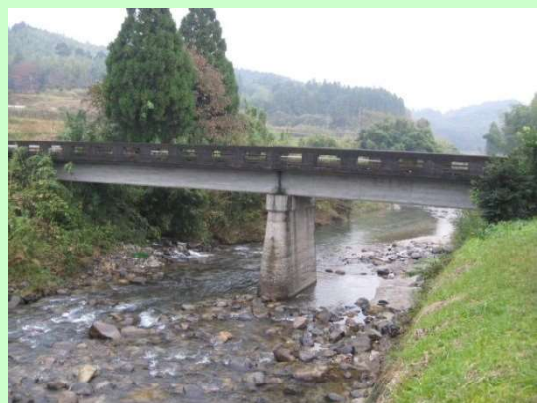
橋梁名: 中間橋 橋種: コンクリート橋(RC T 桁橋) 架設年: 1957(S32)
