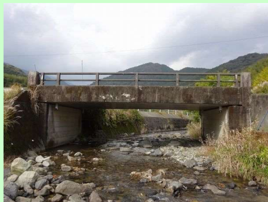
橋梁名: 新改橋 橋種: コンクリート橋(RC 床板橋) 架設年: 1991(H3)
