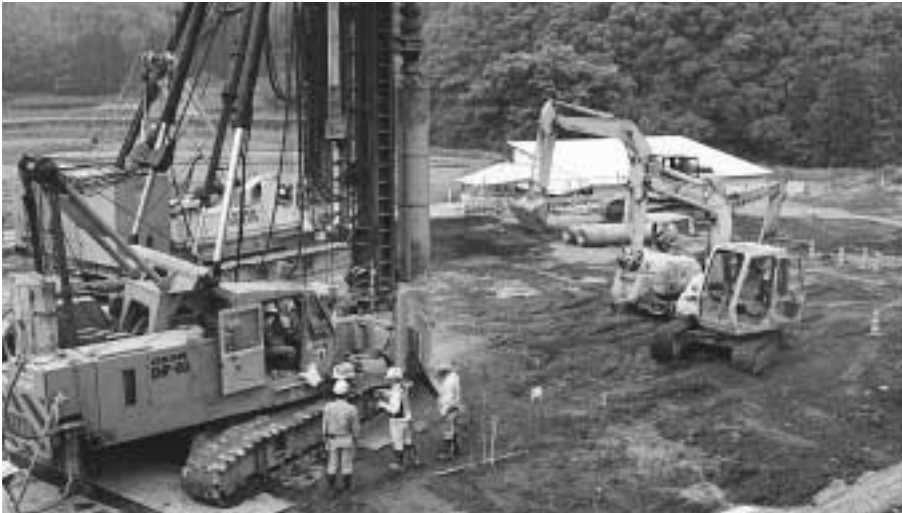
始まった庁舎建設工事
