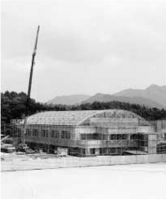
建築が進む中学校屋内運動場
