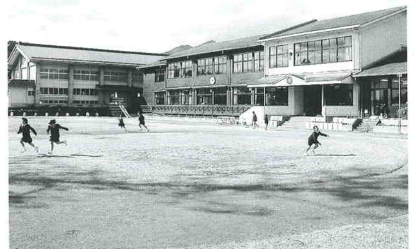
段差や水溜り個所の整備で安全性が確保される
