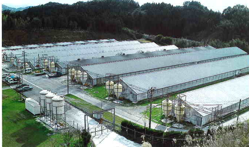
悪臭防止対策として豚舎毎に脱臭装置を設置するよう検討されている
