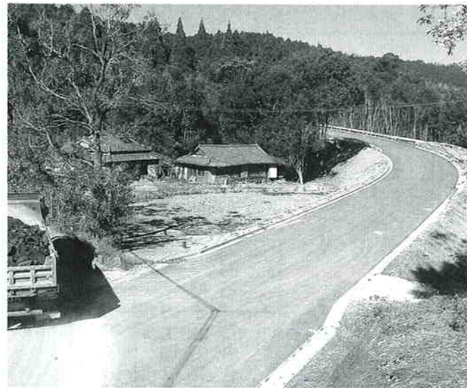
広域営農団地農道等整備事業で工事が進む大平地区
