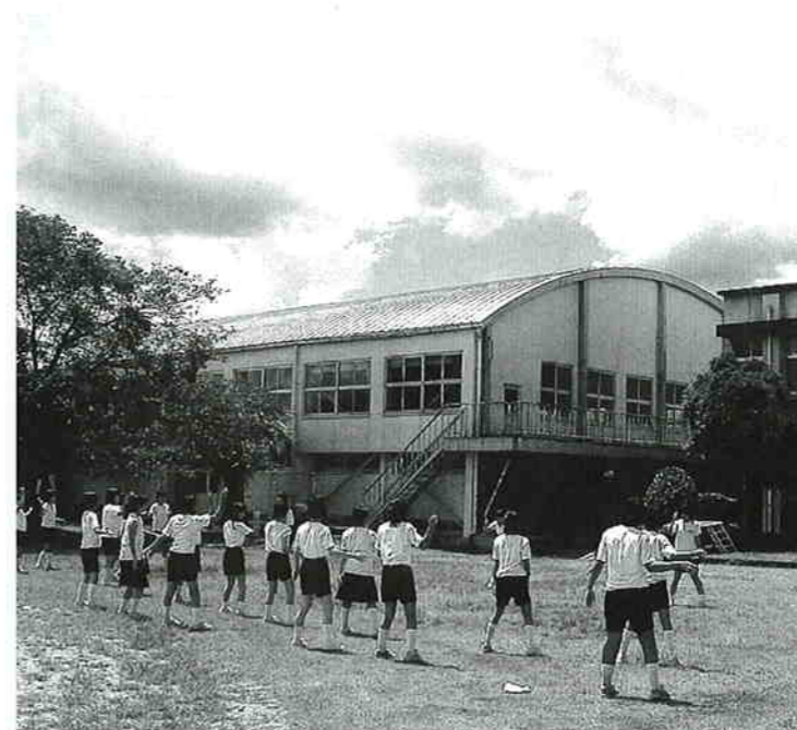
防水工事等の補修を行う鶴田中学校屋内運動場
