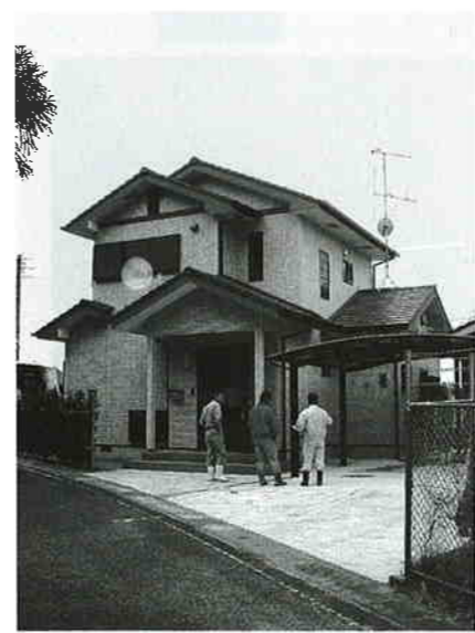
新築された管理舎（湯田原の浄水場）
