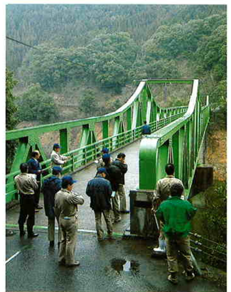
平江橋塗装補修工事現場を調査中の委員会
