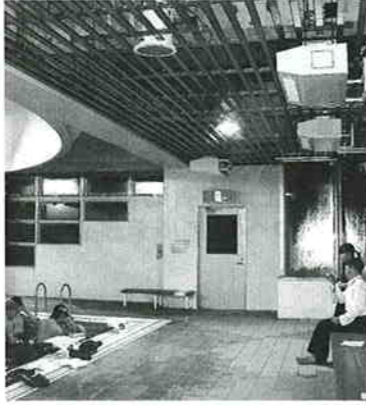
天井に結露防塗剤を吹き付け、換気も十分に行っている「あびる館プール」
