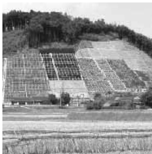
人家裏山の崩壊を災害から未然に防止するため施工された県単治山事業（上手地区）
