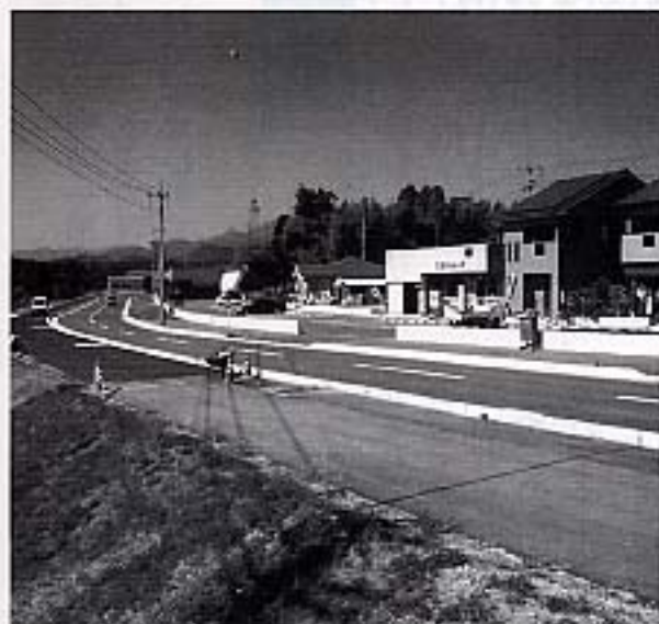
完成間近かな高嶺まちなみ整備事業
