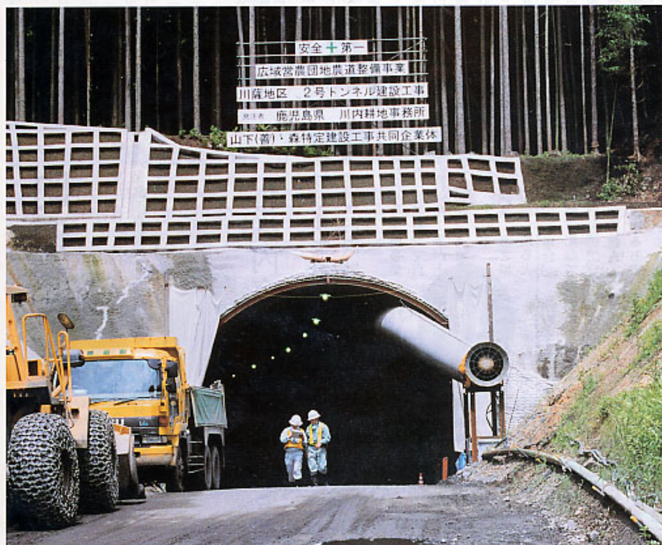
平成16年3月完成を目指す川薩広域農道2号トンネル工事（延長270m、幅員9.7m）＝高嶺側坑口＝
