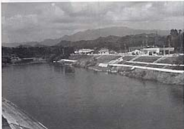
奥薩摩水と緑の郷づくり構想における、水辺の楽校ゾーン周辺（神子橋下流付近）
