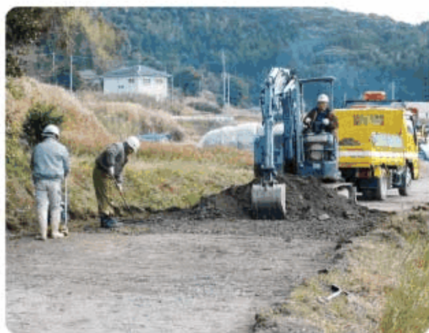
「道路維持作業班」による、身近な生活道路である町道の改良整備
