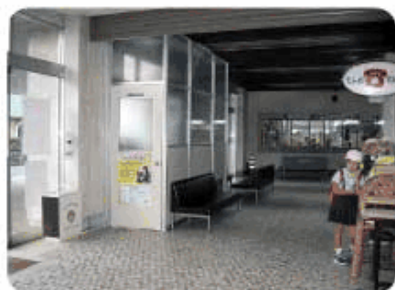
手直しされた喫煙室
