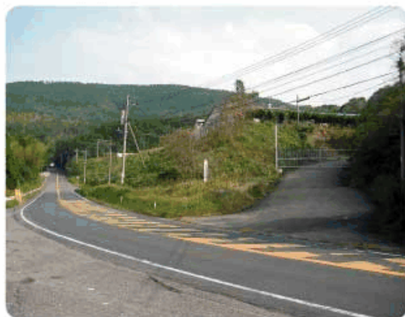
産業廃棄物処理施設の建設予定地（山崎地区）
