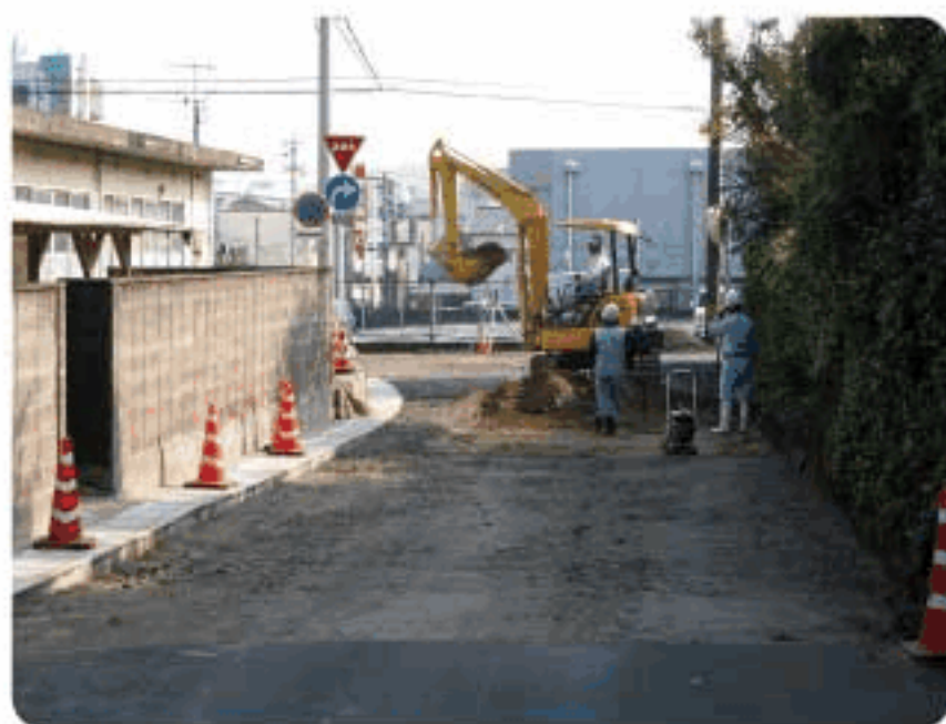
町道維持作業班による補修作業（城之口）
