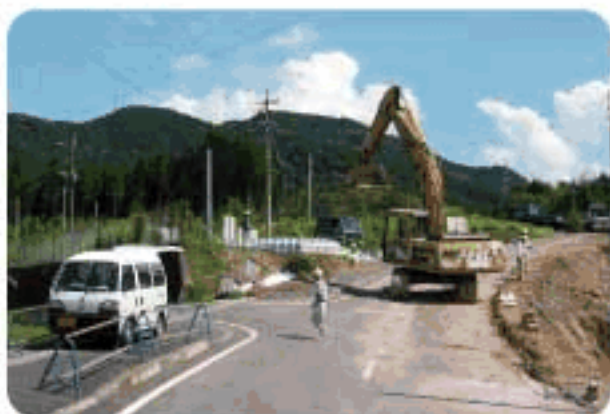
古い住宅は撤去され、取り付け道路の整備も始まった東谷住宅団地
