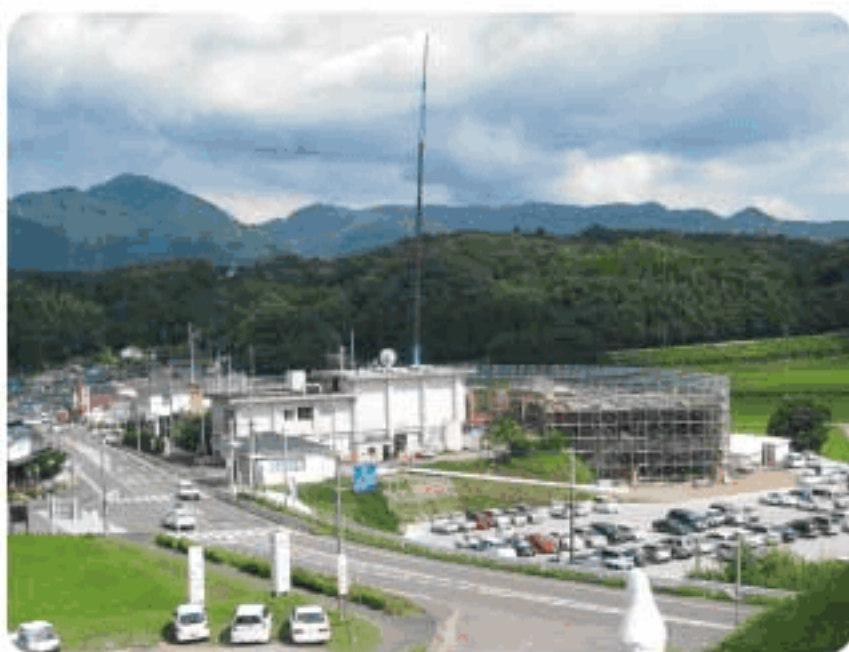
建設中の薩摩町役場新庁舎
