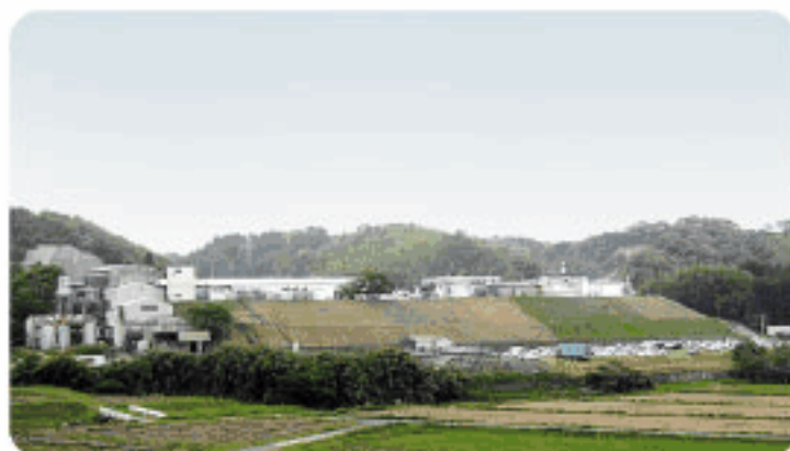
鶏糞発電システム事業の予定地(山崎のアクシース緑の敷地内)
