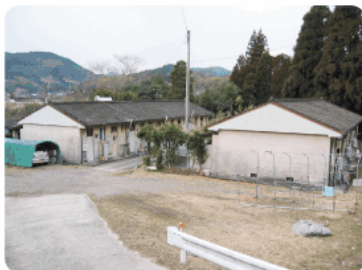
築40年を経過した山崎の町営住宅
