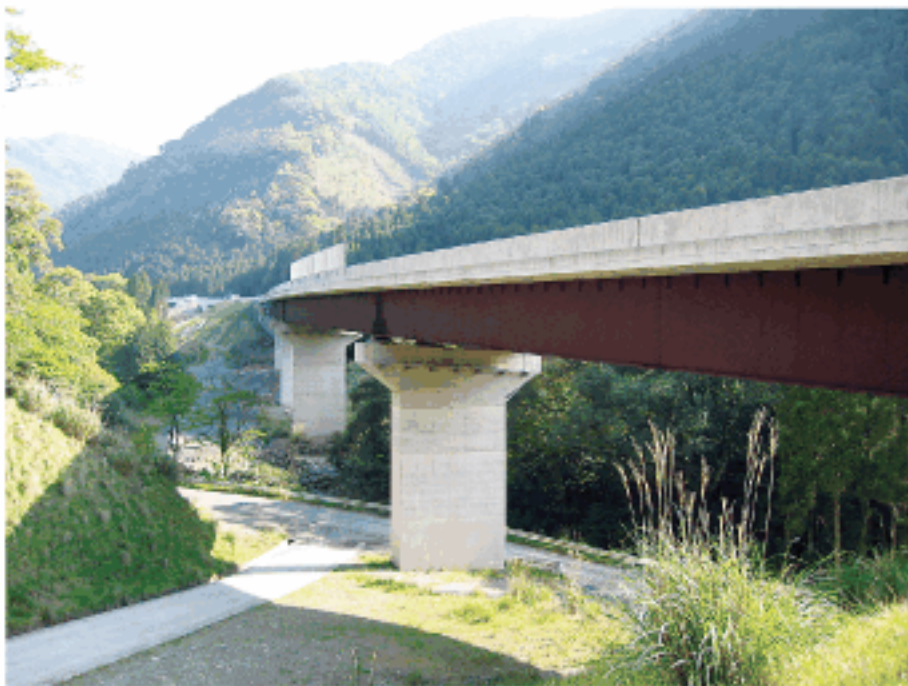
工事が進む国道504号（高尾野町平八重付近）
