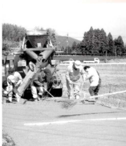
農道整備（久富木地区）
