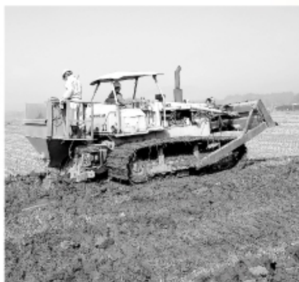
砂防堤排水事業（佐志地区）
