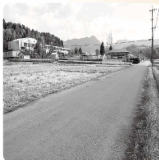
路側帯の区画ラインが引かれる通学路（中津川地区）
