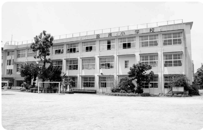
県北西部地震後、耐震補強工事がされた盈進小学校
