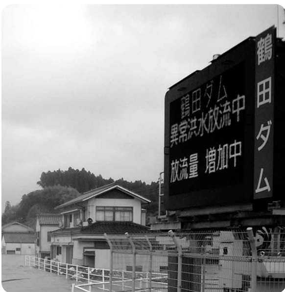
ダムの放流量を表示中の電光掲示板
