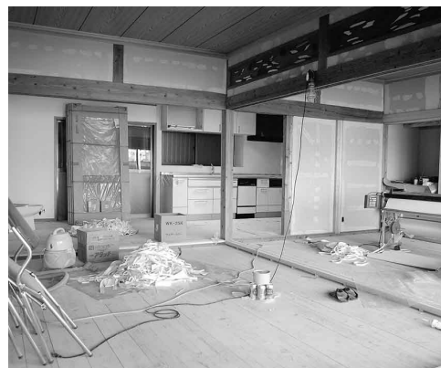
修理中の被災住宅（虎居地区）
