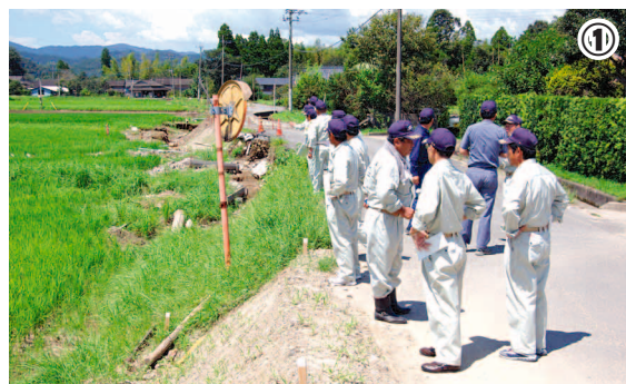
① 8月22日 災害から1か月経ち、復旧状況等の現地調査を実施し、今後の対応を協議
