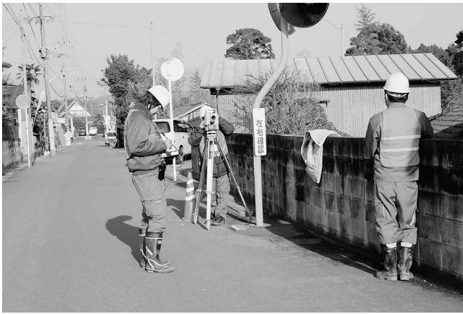
河川改修に向け測量が始まる（虎居地区）
