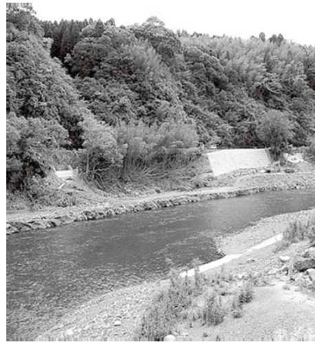
水害により川岸が崩れたホタル舟出発点付近
