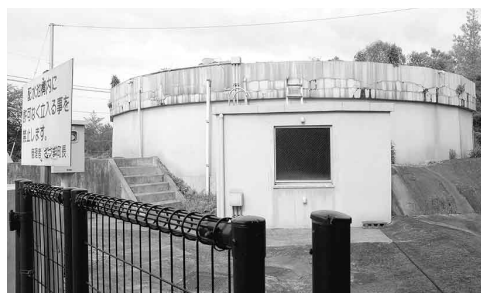
移設される上向配水池（虎居地区）
