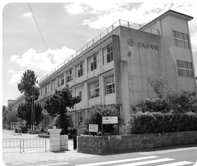
耐震補強されている盈進小学校
