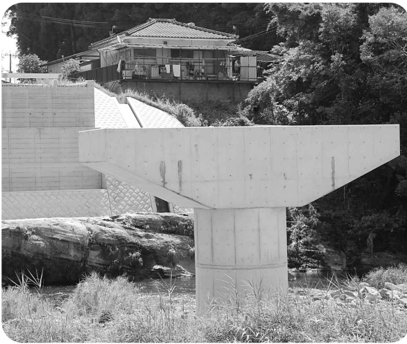
橋脚部分が完成した梁詰橋（佐志地区）
