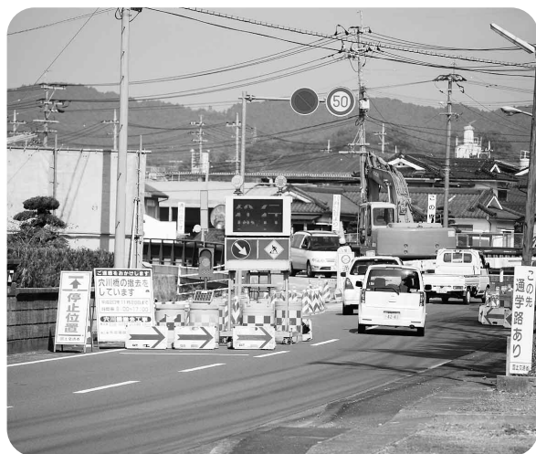
穴川橋の架替工事
