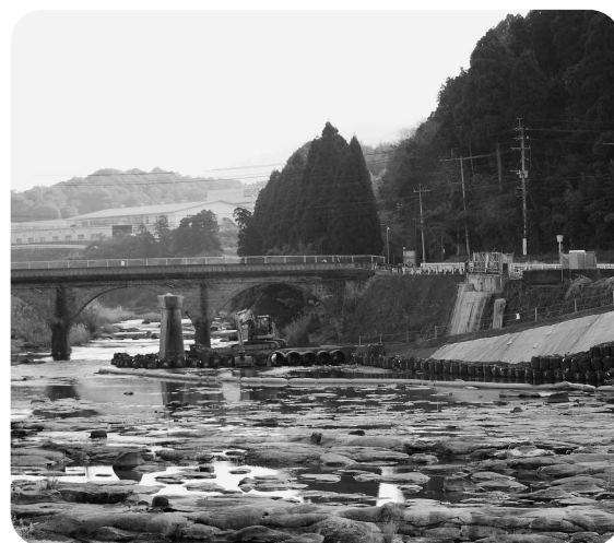
工事が進む穴川橋の架け替え工事
