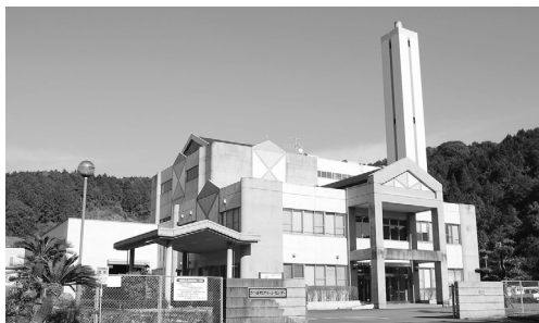
町クリーンセンター
