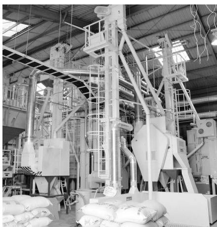
乾燥調整貯蔵施設
