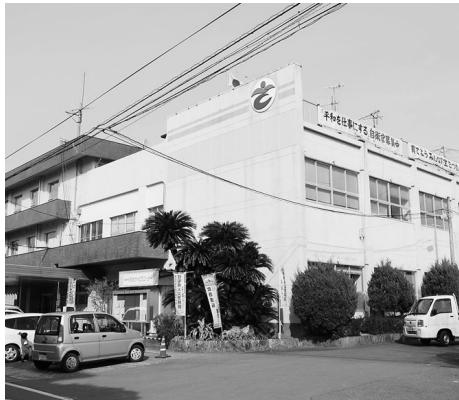
本庁舎 (南側 53 年、北側 40 年が経過)
