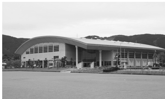
改修が予定されている総合体育館
