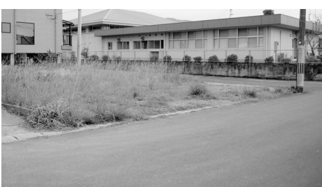
建設予定地（右奥は虎居地区公民館）
