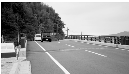
歩道橋の設置が計画されている川原橋
