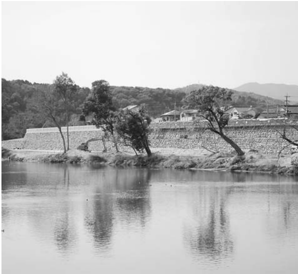
景観に配慮して整備された築堤（虎居地内）
