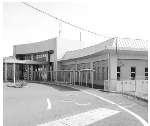
子ども図書館の設置が計画されている薩摩支所
