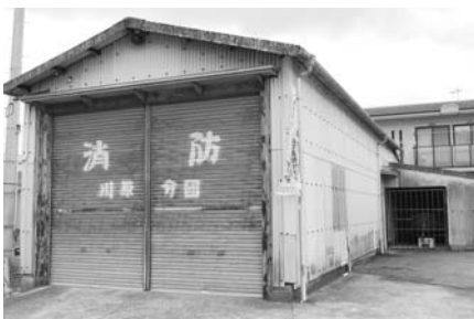
老朽化が進んだ現在の川原分団車庫
