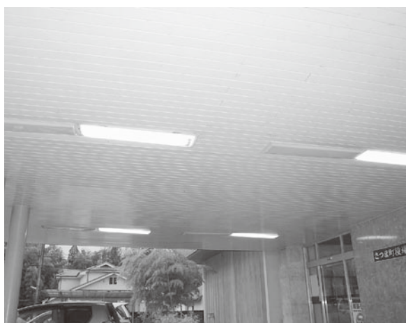
節電対策として一部の蛍光灯が外された庁舎玄関
