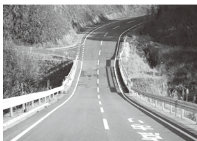
橋梁整備が完了した狩宿大平線
