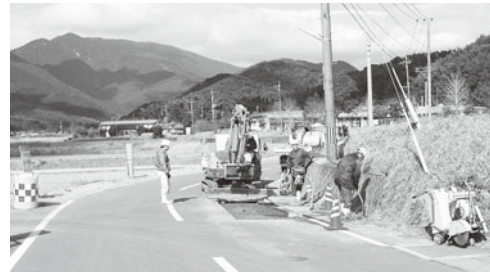
道路整備員による要望箇所の補修工事
