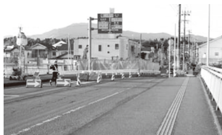
延伸工事が始まった宮之城橋(虎居)
